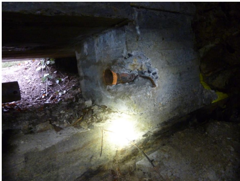
Système de fermeture détérioré (photo du 21 janvier 2018) © CEN Allier
