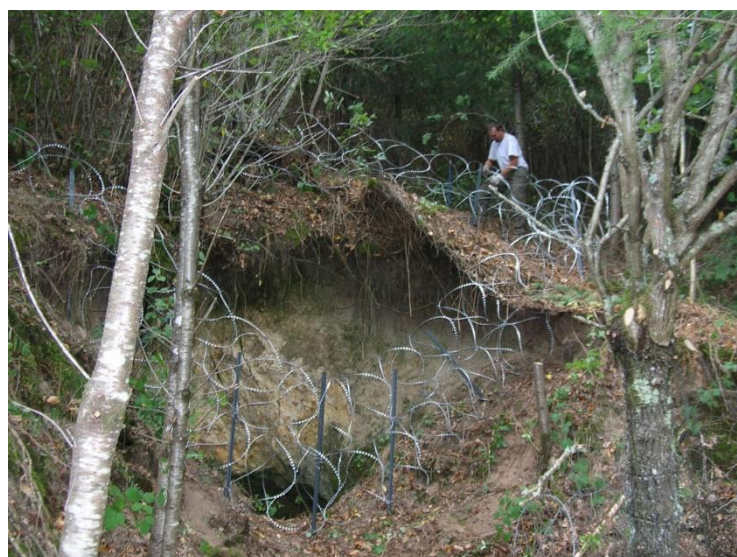
Mise en sécurité du puit © R. LEGRAND
