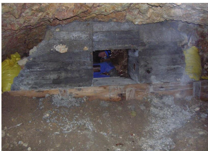
Dispositif de fermeture terminé (en position ouverte) © Y. DAUPHIN
