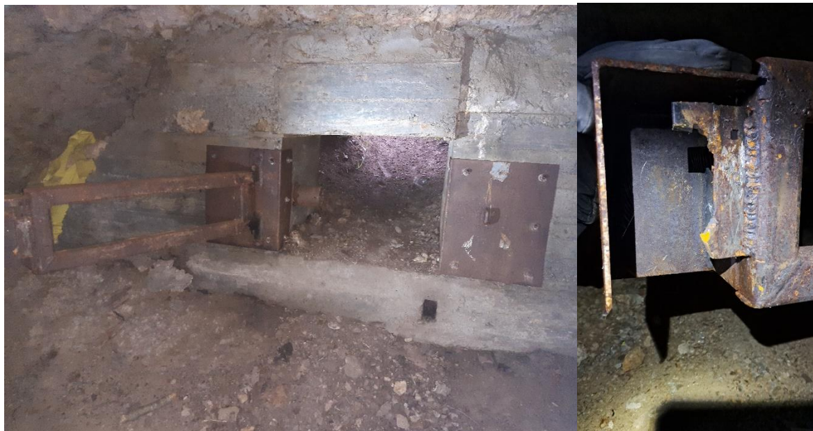
Système de fermeture détérioré (photos 2024) © CEN Allier
