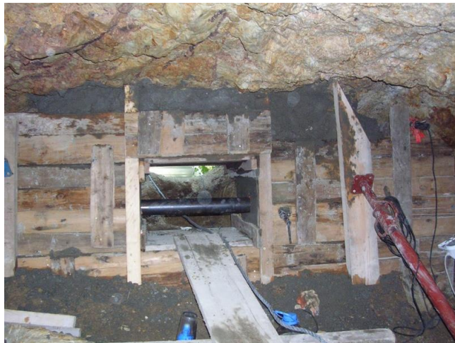
Dispositif de fermeture mis en place, avant retrait du coffrage © CEN Allier
