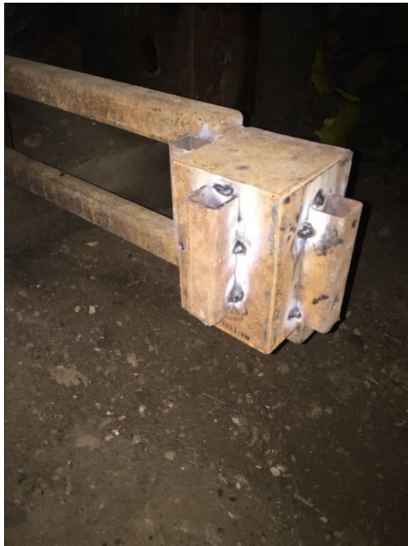
Photos avant soudure sur la cage (gauche) et après soudure, cage renforcée (droite) © CEN Auvergne
