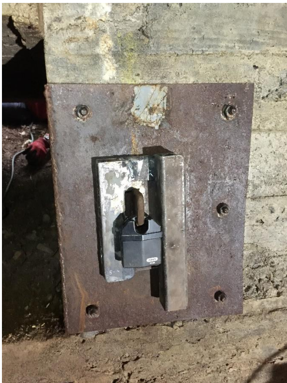
Photos avant soudure sur la cage (gauche) et après soudure, cage renforcée (droite) © CEN Auvergne
